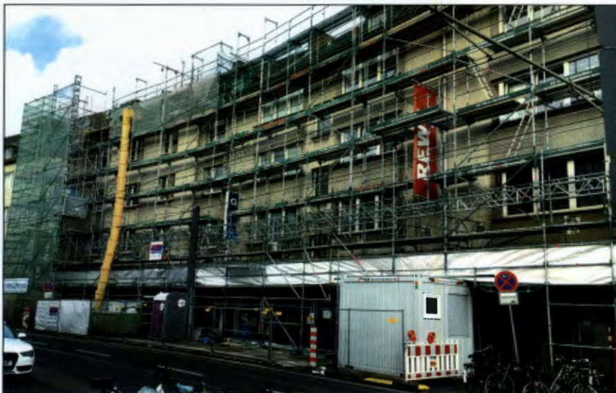
Sanierung eines Wohn- und Geschäftshauses in Köln.
